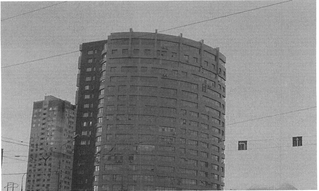
Балаклавский проспект, д. 16 Конструкции не выявлены Фотография по состоянию на 02.11.2015
